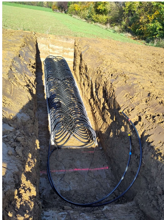
Abbildung 22: Einbau des 8er-Kollektors der Fa. Freisolar
