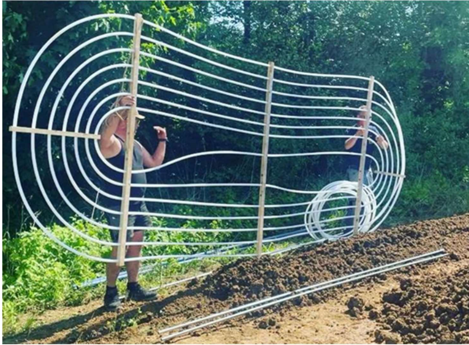
Abbildung 21: Vertikaler Einbau des Boden-Klima-Tauschers der Fa. Steinhäuser
