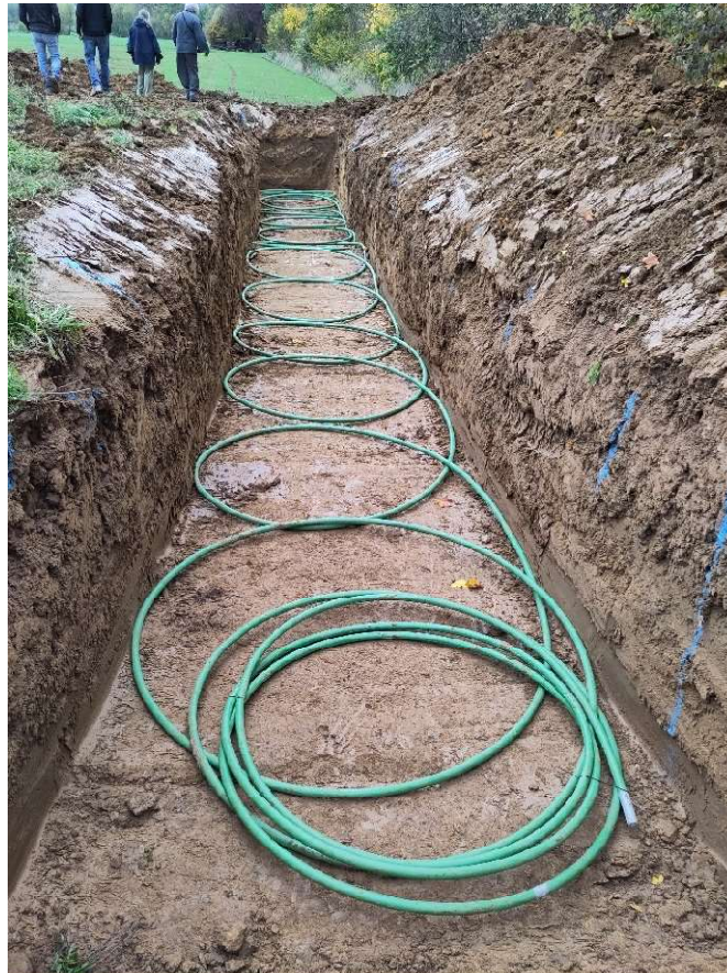
Abbildung 23: Einbau des Ringgrabenkollektors der Fa. RGK
