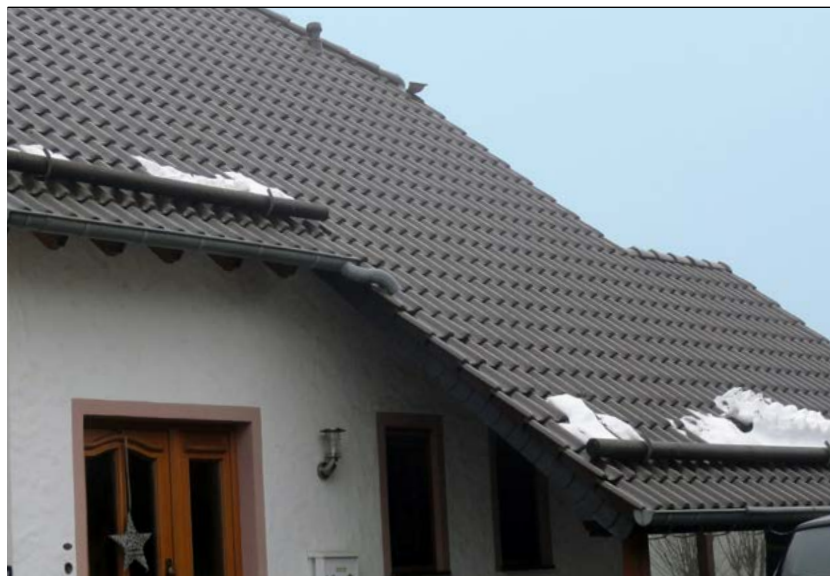
Schneestoppvorrichtung zum Schutz vor Dachlawinen
